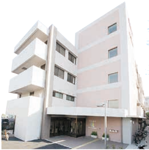
きらり港北外観
